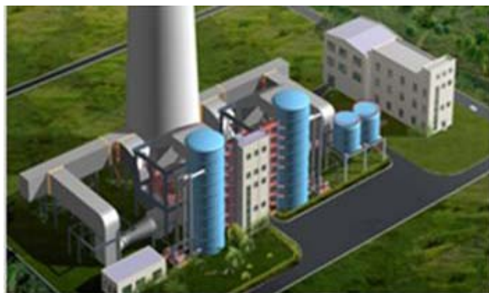
图 1-2 石灰石-石膏湿法烟气脱硫系统示意图
