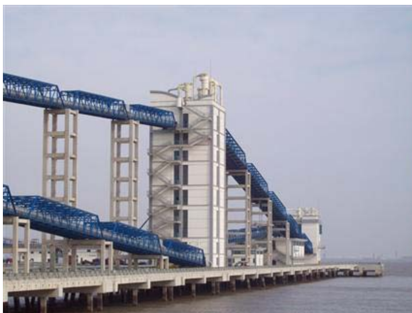
图 6-14 现场工程照片
