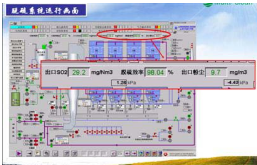
图 2-18 本项目 4#烧结机脱硫装置运行 DCS 画面
