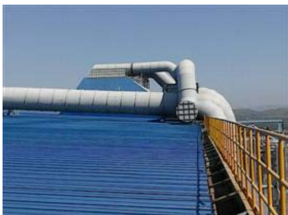
图 2-71 容量屋顶贮留集尘罩
