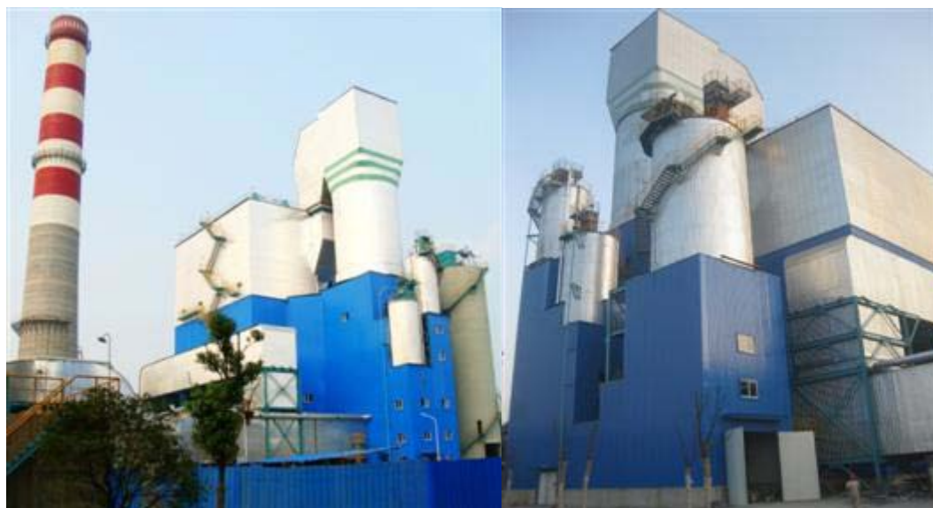
图 2-23 案例 4#现场图图 2-24 案例 5#现场图
