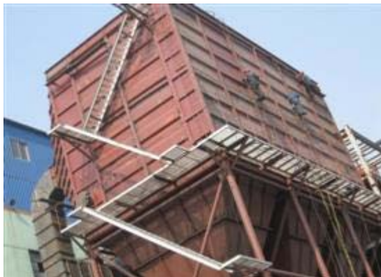
图 1-101 除尘器安装图
