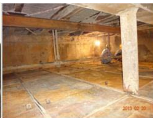
图 1-73 再生后 SCR 反应器图
